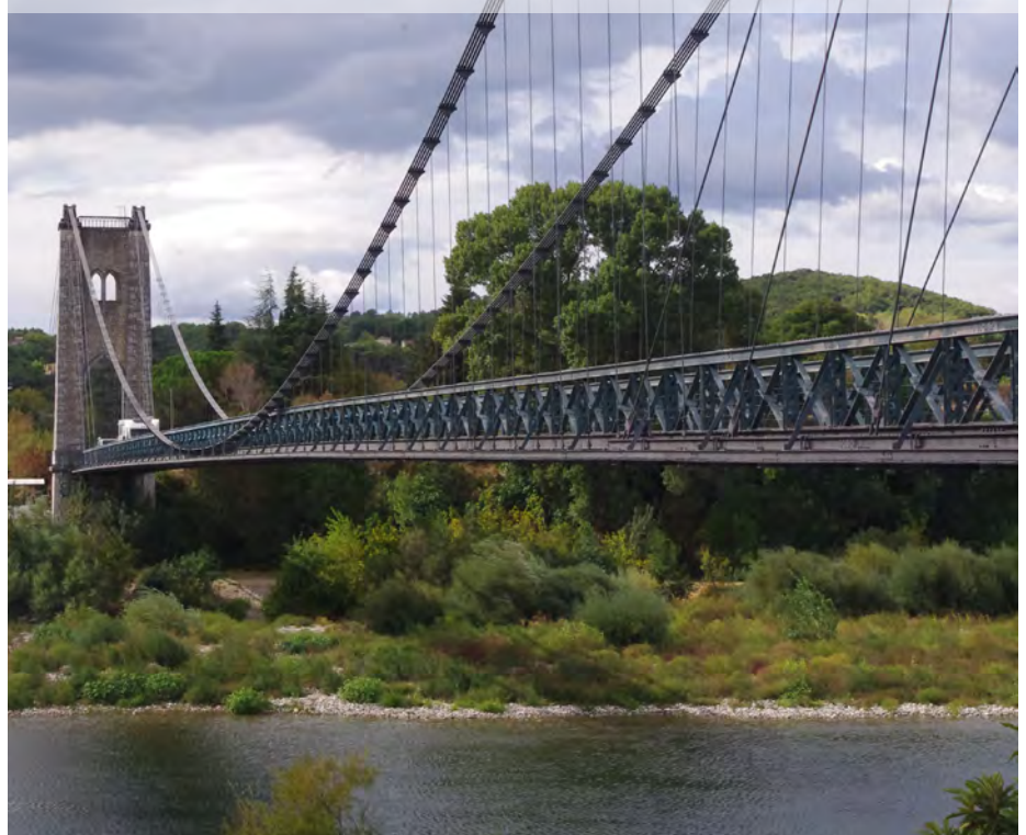
Élément bâti repère : le pont entre St-Martin d'Ardèche et Aiguèze
