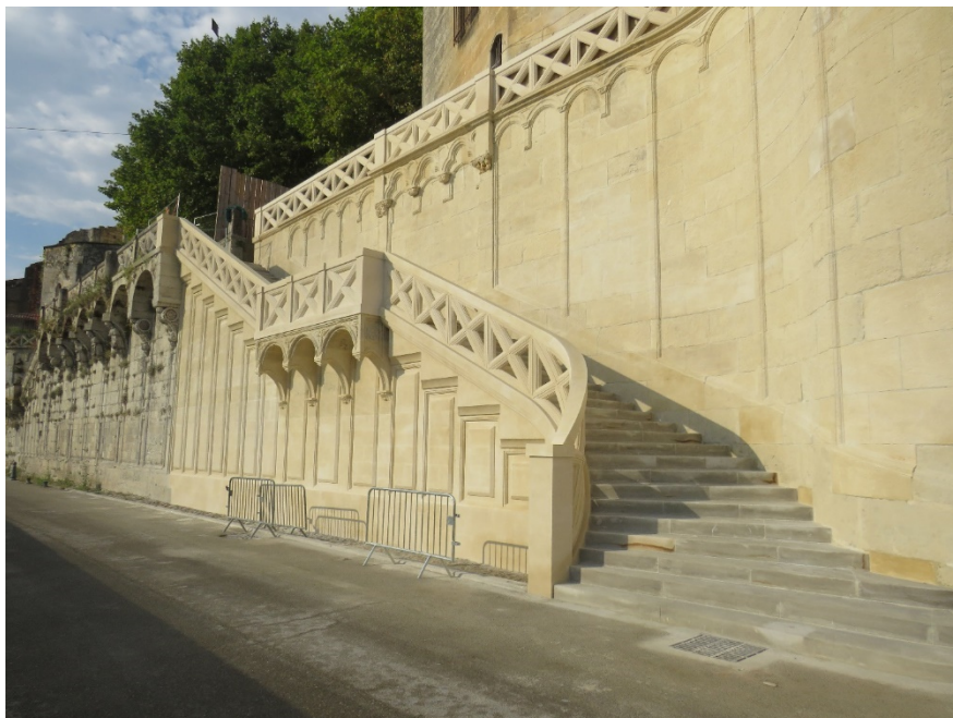
Tranche ferme restaurée
