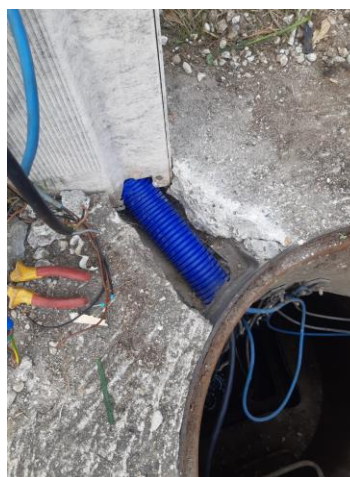
Reprise du fourreau
