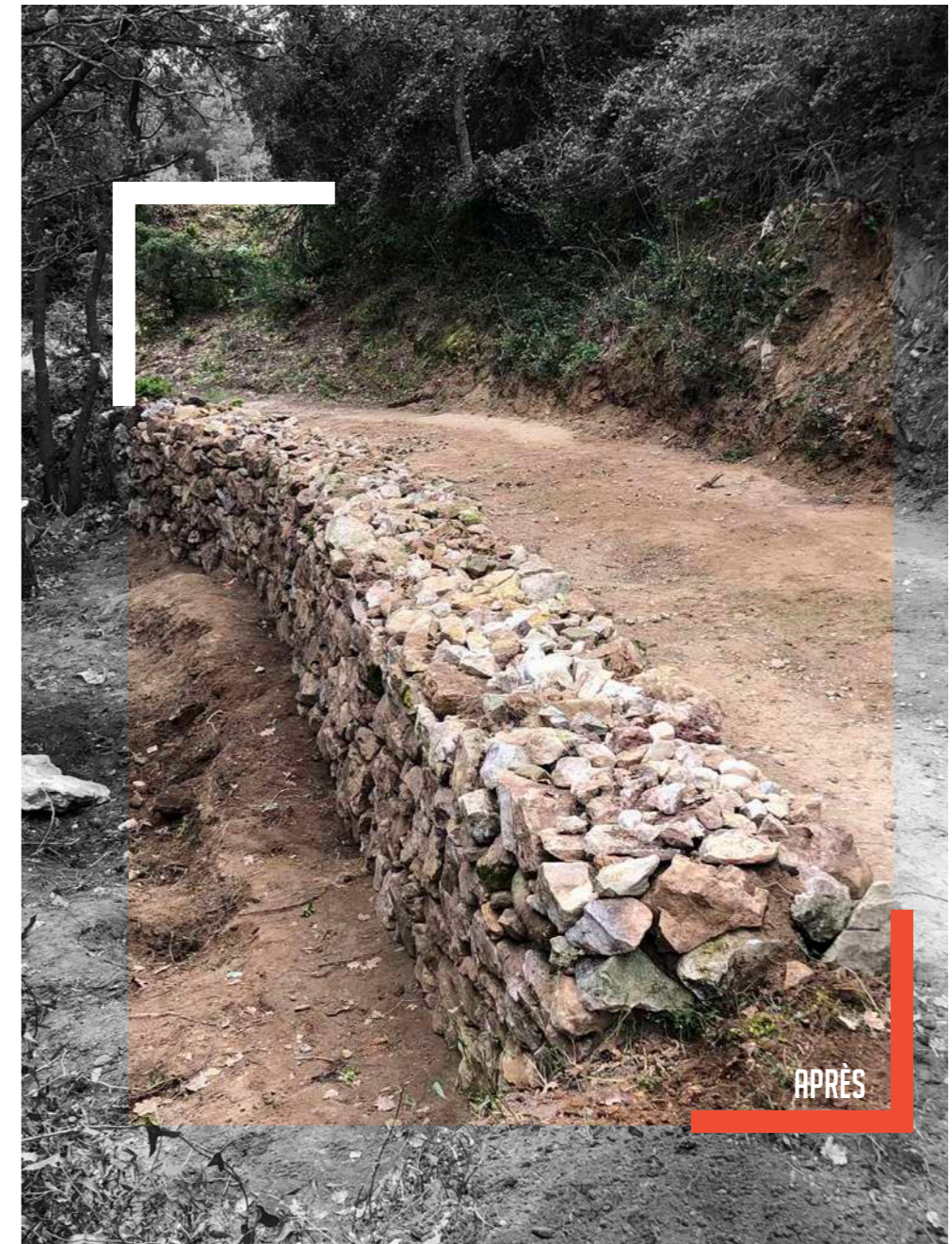
RÉFECTION MURET ACCÈS CHAPELLE
