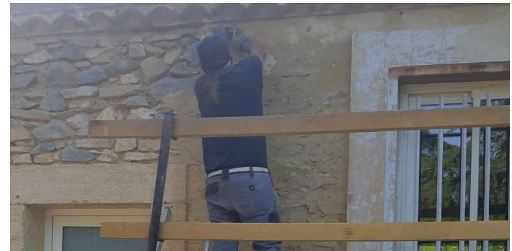
DÉCROUTAGE FAÇADE ANCIENNE POSTE
