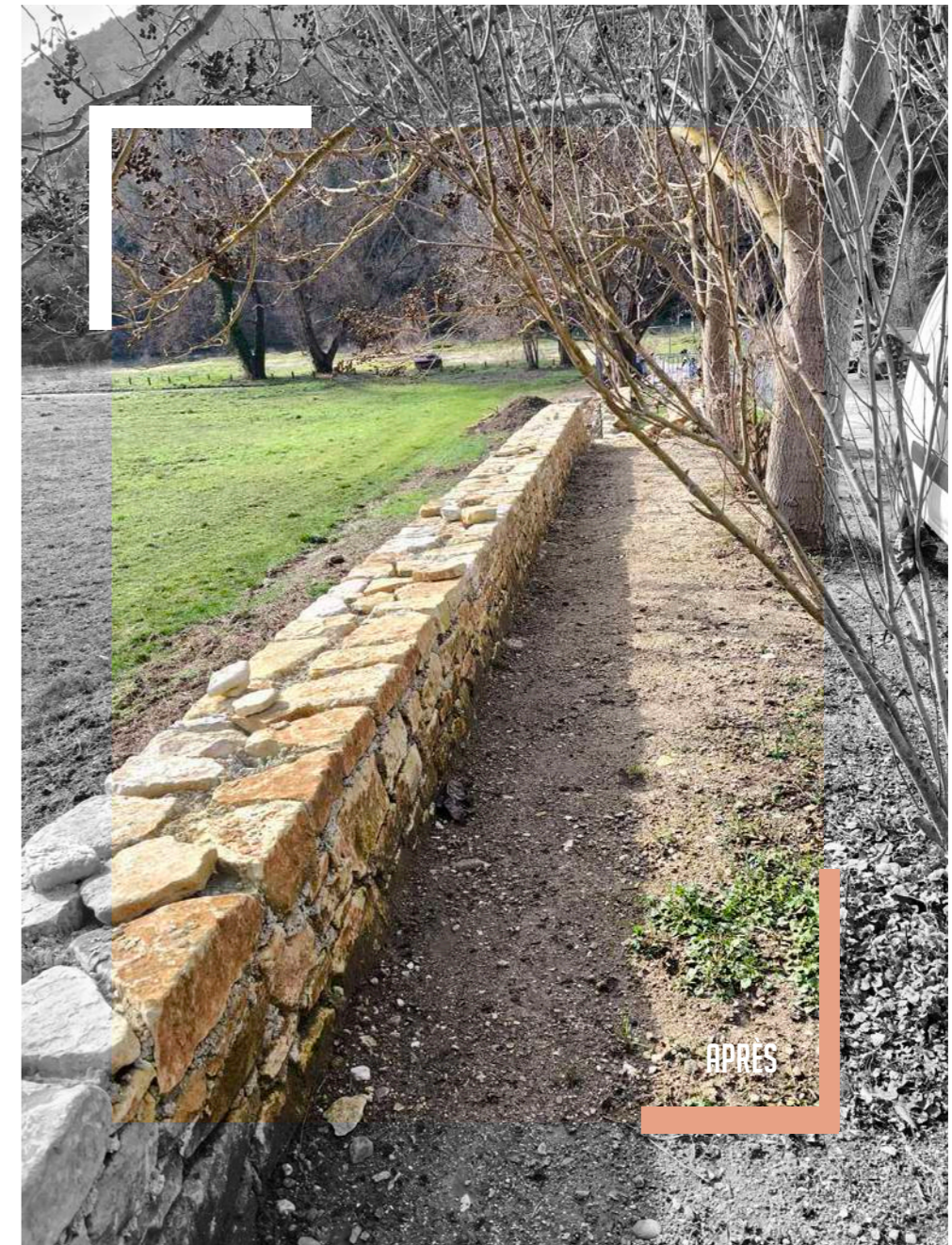
RÉFECTION - CRÉATION D'UN MUR
